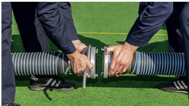
Abb. 29: Kuppeln der Saugschläuche mit angesetzten Kupplungsschlüsseln (ÖBFV)
